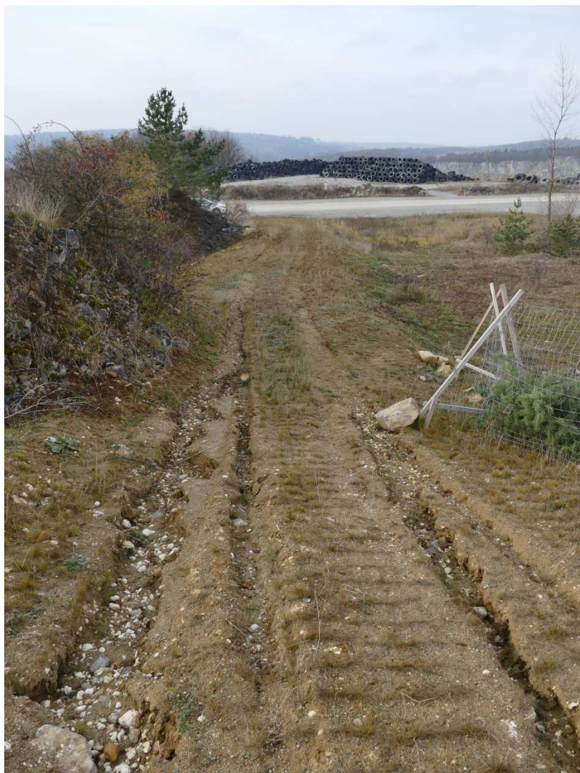
Erozní rýhy vzniklé ve vyjetých kolejkách na přístupové cestě.
