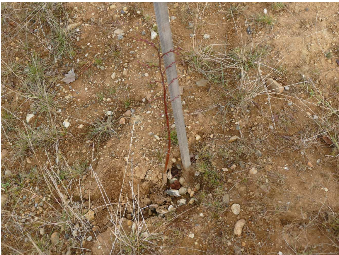
Drobná eroze vzniklá sekundárně rozrušením svahu výsadbou.
